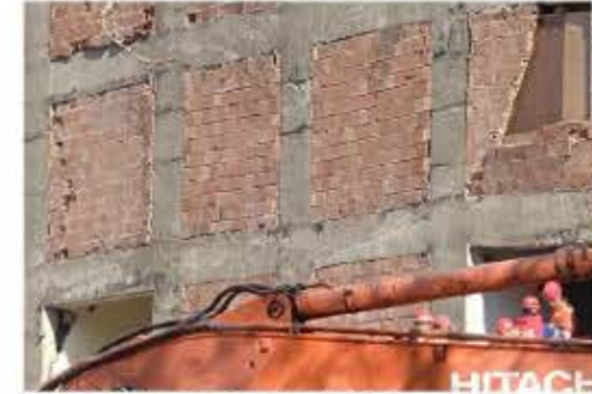
写真1 フラットスラブ構造+中空煉瓦壁
