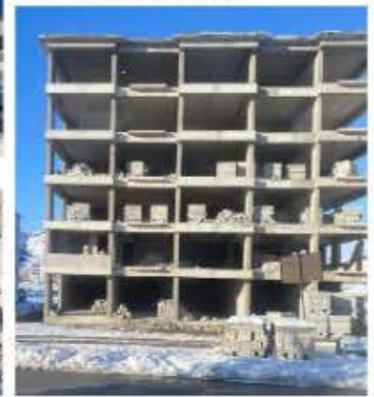
写真5 建設中の建物
