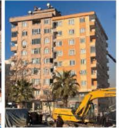
写真4 隙間が少ない隣接建物
