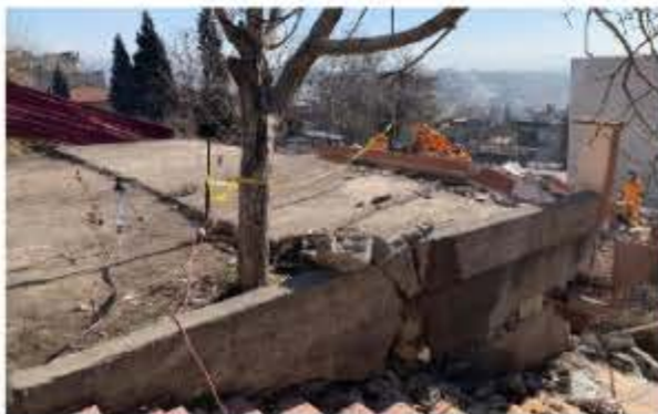
写真10 上部からコンクリートを斬ってアプローチする隊員
