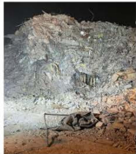
写真12 ダブルTポストショア2基で空間を確保
