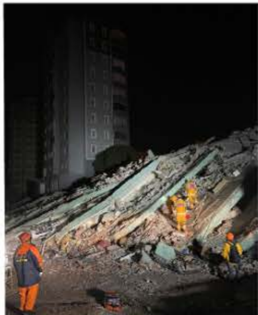
写真8 被災建物と健全な隣接建物との対比
