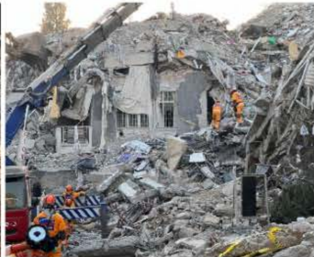
写真13 重機で支持された建物内をサーチ
